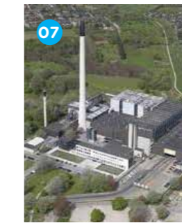
07 VESTFORBRÆNDING Waste-to-energy CHP
