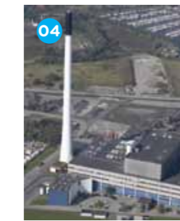
04 AMAGERFORBRÆNDING Waste-to-energy CHP
