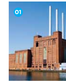
01 DONG ENERGY SVANEMØLLEVÆRKET Gas-fuelled CHP
