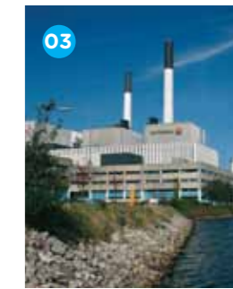
03 VATTENFALL AMAGERVÆRKET Multi-fuel CHP, heat storage
