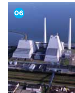
06 DONG ENERGY AVEDØREVÆRKET Multi-fuel CHP, heat storage
