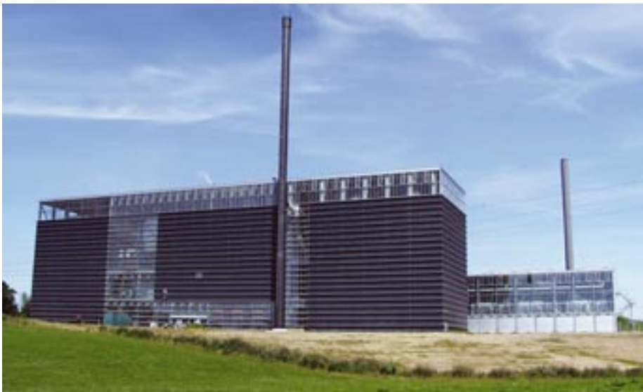
Svendborg Kraftvarmeværk. Architects: Boje Lundgaard & Lene Tranberg
