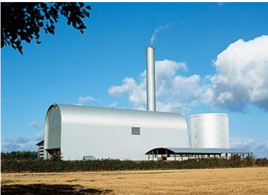
Sønderborg Kraftvarmeværk. Architects: Friis & Moltke A/S
